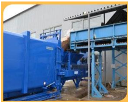
7. Конвейер реверсивный для подачи несортируемого ТБО в мусороперегрузочные прессы
